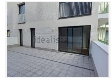
Aprestadora 81 New Build
