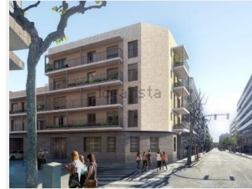
AV santa Eulalia 129 New Build
